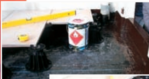
Plots PVC à vérins Ajustement et réglage par laser rotatif
